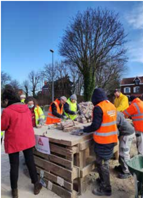
Construction d'un logement de gardien en briques récupérées, Sains-en-Gohelle (62)
