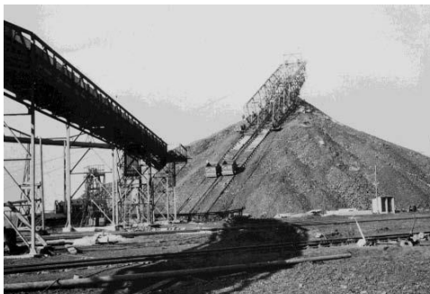
Tête de versage, système de mise à terril par skip @Coll. JM Minot
