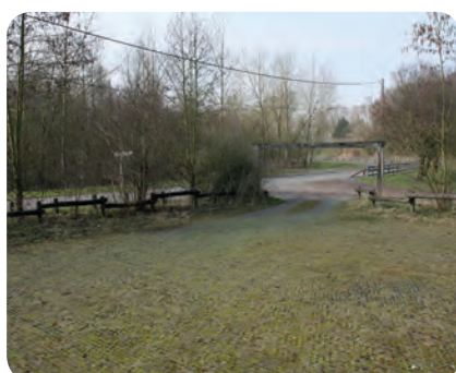
Parking en dalles alvéolées engazonnées, Mission Bassin Minier
