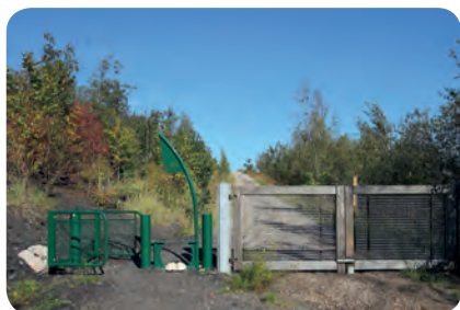
Association d'une barrière sélective PMR, d'un pass'vélo et d'un portail bloquant les 2 roues motorisées, S. Dhote
