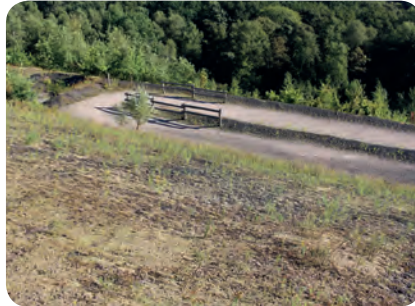
Zone de rétention d'eau dans la continuité du cheminement, Mission Bassin Minier
