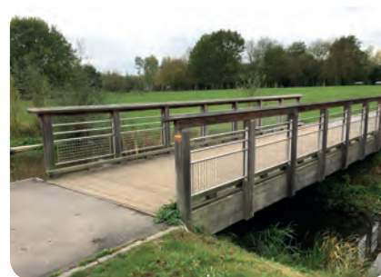
Passerelle en bois et métal, Mission Bassin Minier
