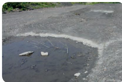
Système de terrassement, Mission Bassin Minier
