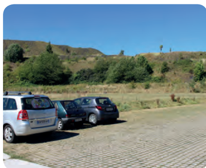
Parking en dalles béton enherbées filtrantes, Mission Bassin Minier
