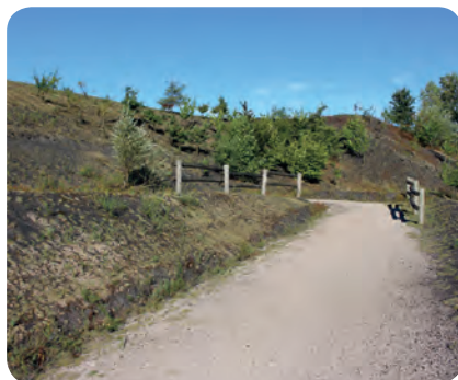
Rampe d'accès PMR : pente douce et palier permettant des pauses durant l'ascension. Mission Bassin Minier
