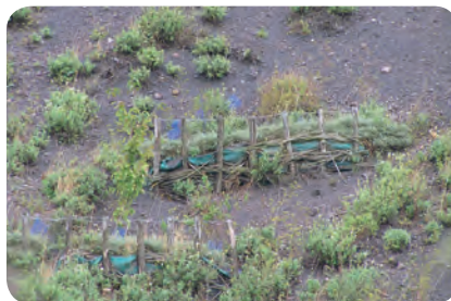
Fascinage sur une pente, BM
