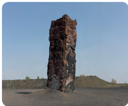
Terril 101 : vestige mis à jour par l'exploitation d'un pied de téléphérique dans lequel s'est accumulé et compressé du schiste. Mission Bassin Minier
