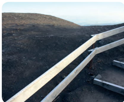
Un garde-corps mis en place avant le sommet du terril pour canaliser le public. Sobre et fait de chêne, il se fondra dans le paysage en grisonnant avec le temps. Mission Bassin Minier
