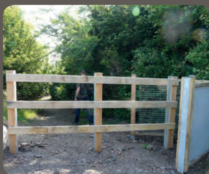
L'entrée sur l'espace naturel sensible est marquée par une barrière sélective. Mission Bassin Minier
