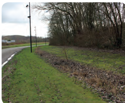
Noue en limite de site, Mission Bassin Minier
