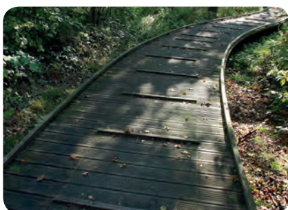
Platelage bois en zone humide, un grillage posé sur le platelage assure la fonction anti-dérapante, S. Dhote
