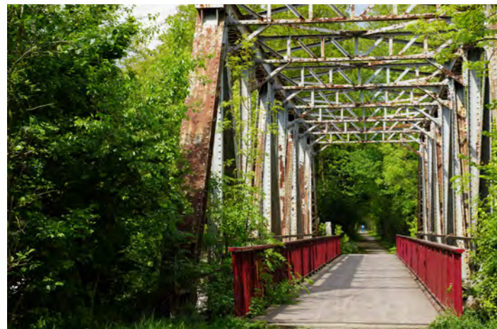
Viaduc du cavalier Somain-Péruweltz, à Condé-sur-l'Escaut.
