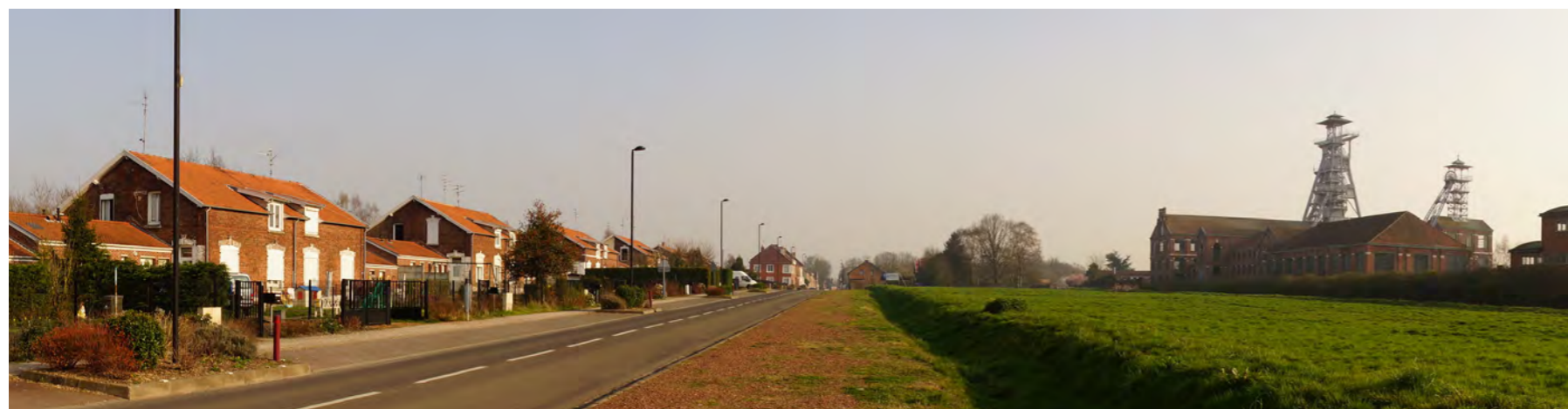
Vis à vis entre la fosse et la cité d'Arenberg, autour de la D313.
